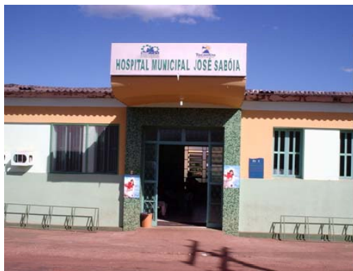
Figuras 140 e 141 – Hospital Municipal José Sabóia – Tocantinópolis
