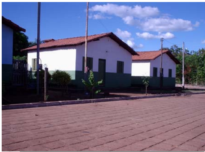
Figura 190 – Casas Populares do Bairro Alto da Boa Vista II - Tocantinópolis
