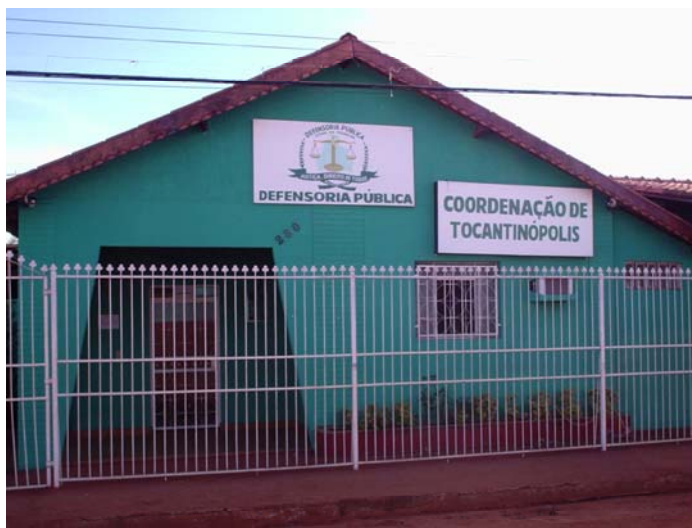
Figura 78 – Defensoria Pública – Tocantinópolis (2007)
